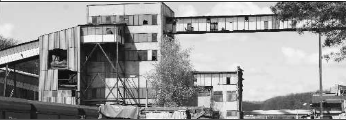
Na tomto zábere mnohým bývalým baníkom určite niečo chýba. Mohutný komín kotolne rozobrali začiatkom roka
